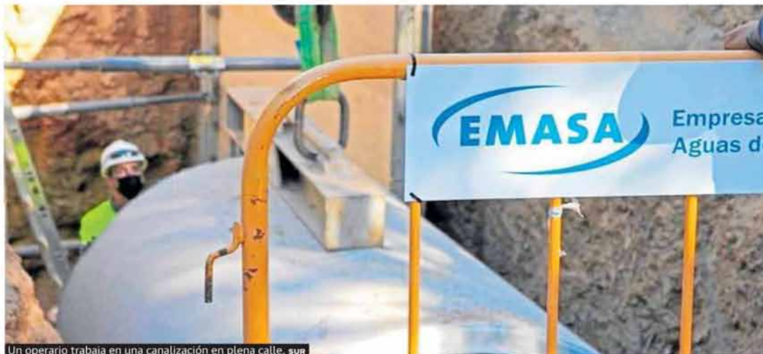
Un operario trabaja en una canalización en plena calle. sur
