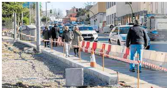
Los trabajos han obligado a levantar el suelo.
