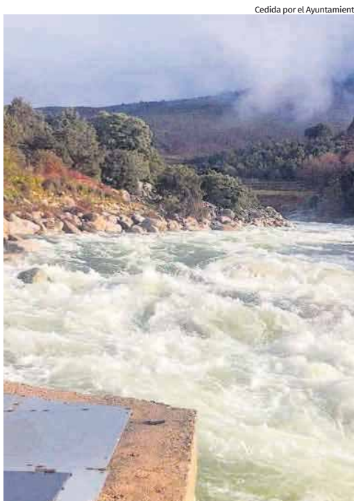
La captación de agua de Madrigal de la Vera.
