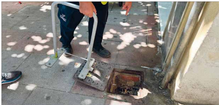
INTERVENCIÓN. Un operario del servicio de tratamiento de plagas levanta un registro en la vía pública.
