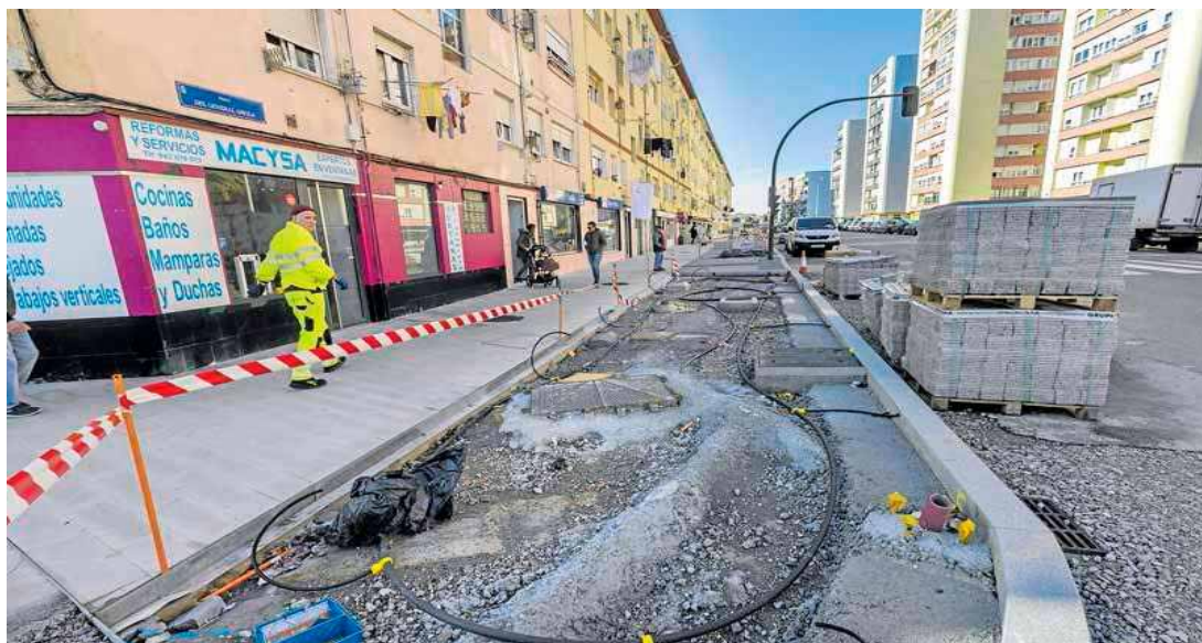
Varias personas caminan, ayer, junto a los trabajos de renovación de General Dávila, cuyo final se retrasa hasta junio. FOTOGRAFÍAS: ROBERTO RUIZ
